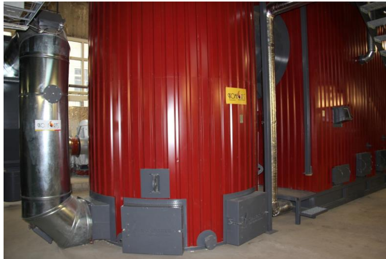
5.7.att.Jaunais ūdenssildāmais šķeldas katls
