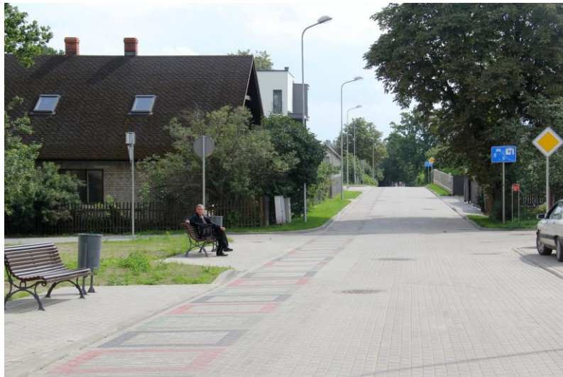
5.2.att.Rekonstruētā Baložu iela Tukumā
