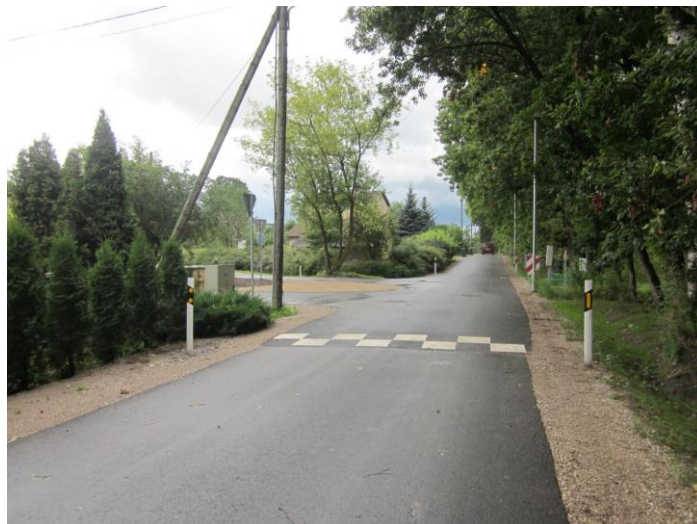
5.6.att.M.Parka ielas posms
