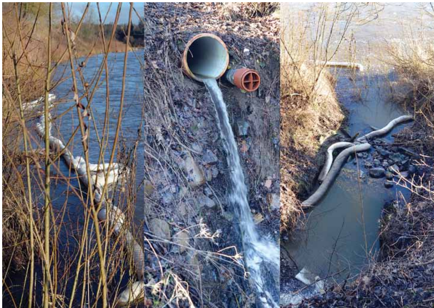
Vieta, kur Ventā ieplūduši naftas produkti, ir norobežota ar četrkārtēju bonu joslu, kas šo vielu uzsūc.
