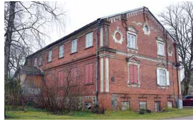
Mucenieku iela 8. Starpstāvu pārsegums avārijas stāvoklī, tas ir stiprināts.
