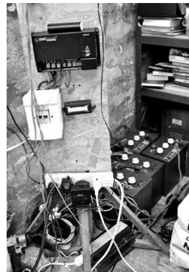
Elektrifikācija pašu rokām.
