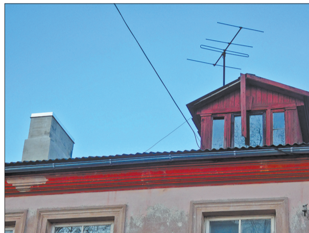
Pārmūrēti skursteņi – Aglonas ielā 18
