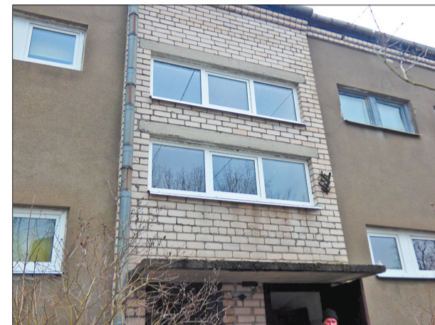
A. Upiša ielas 10 kāpņu telpā uzstādīti PVC logi
