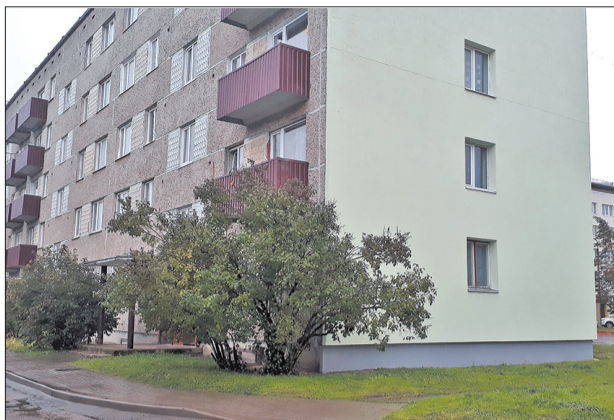
Daugavpils ielā 70 – atjaunotas sānu fasādes
