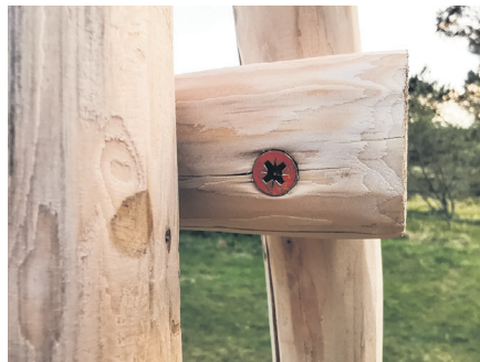
Kāršu sastiprināšanai jāizmanto skrūves, citādi viss sabruks.
