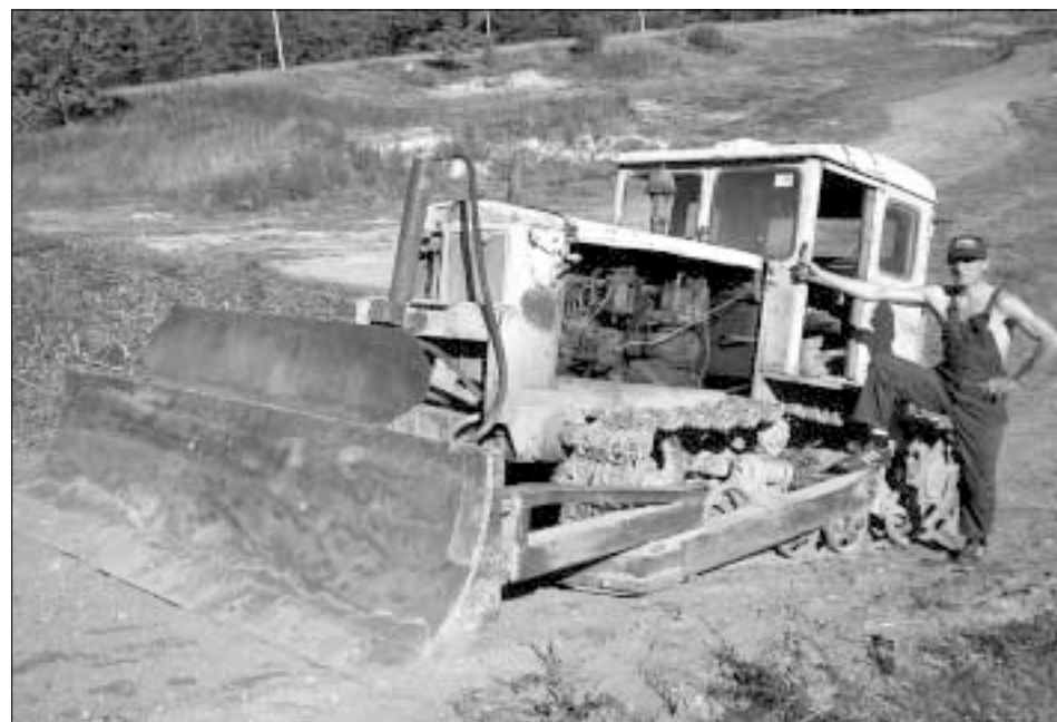
Antons Radzevičs ar buldozeru veido trasē "Celmji"
