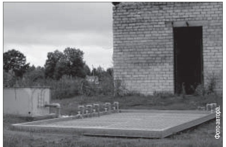
Новые очистные сооружения.
