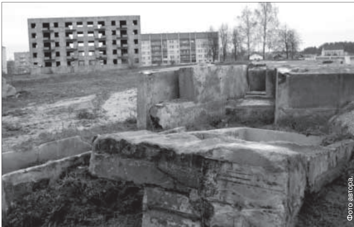
Здания, отданные под снос.
