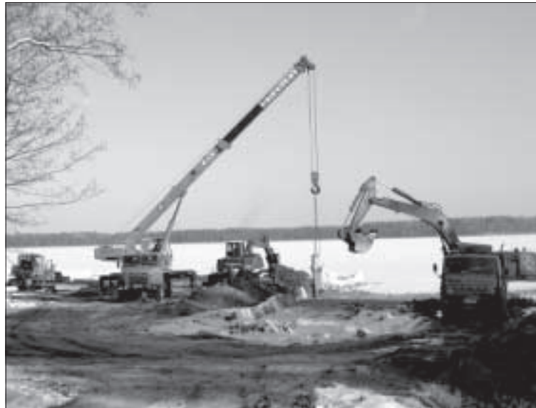
Ведется очистка пляжа.
