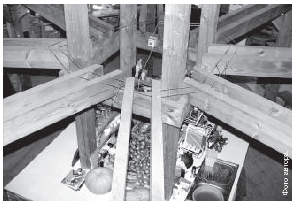
Вид на первый этаж со второго этажа.
