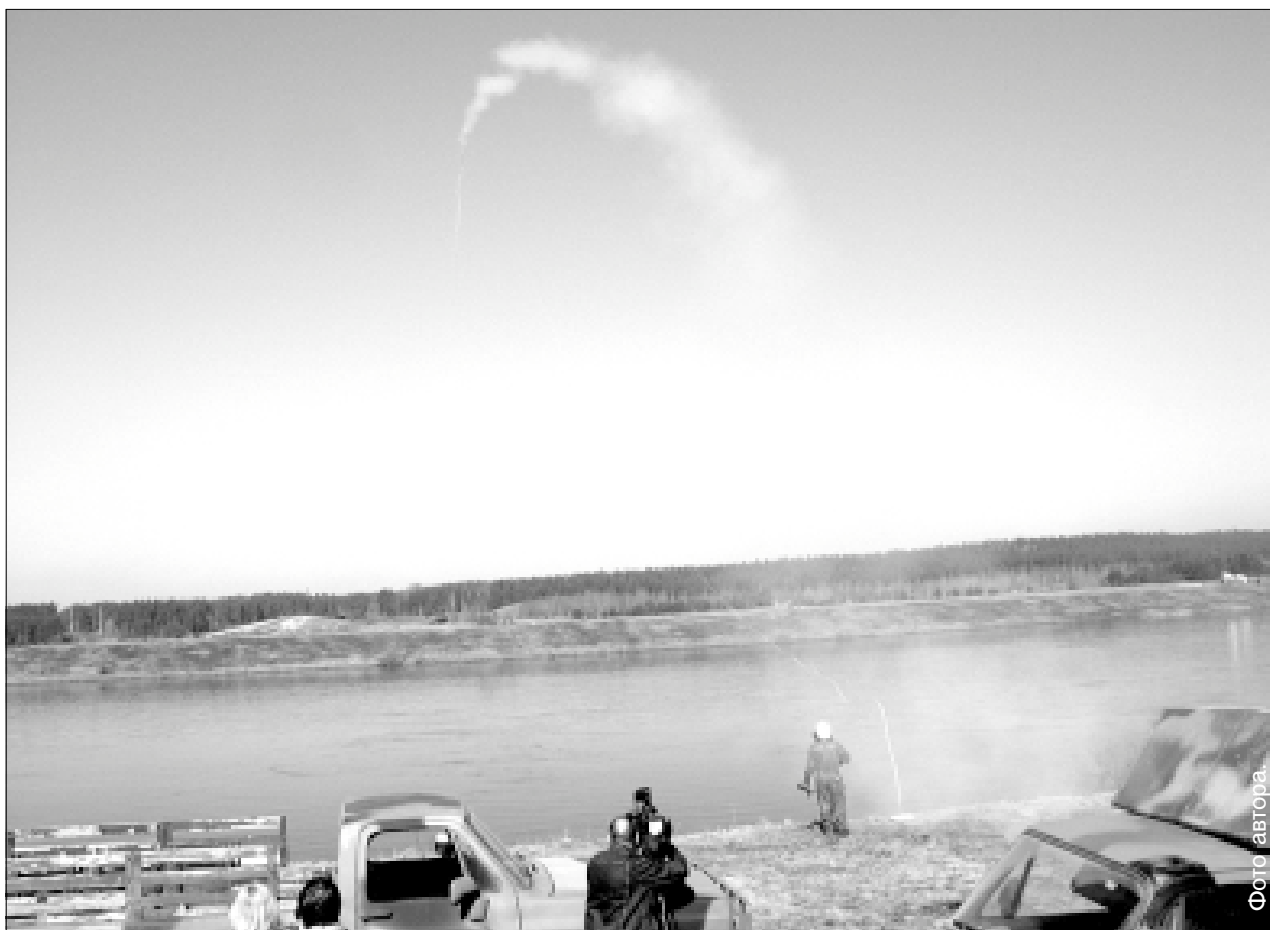
На противоположный берег специальным выстрелом забрасывают трос.
