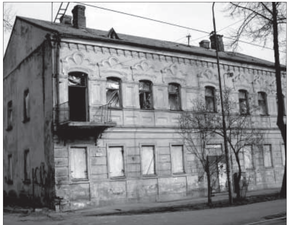
Здание на ул. 18 Новембра.
