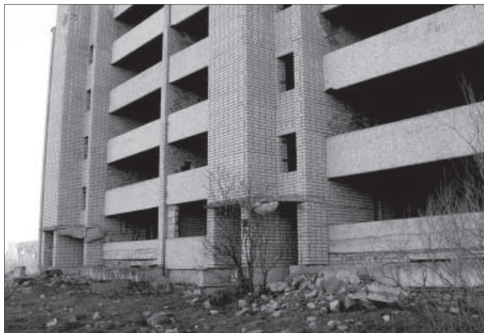
Незавершенное строительство на ул. Цесу.
