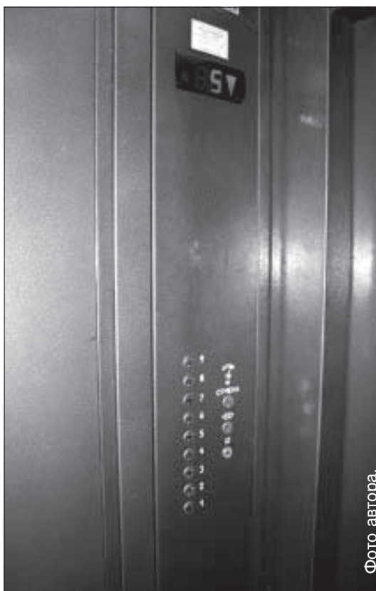
Новый лифт в девятиэтажном доме на улице Виестура.
