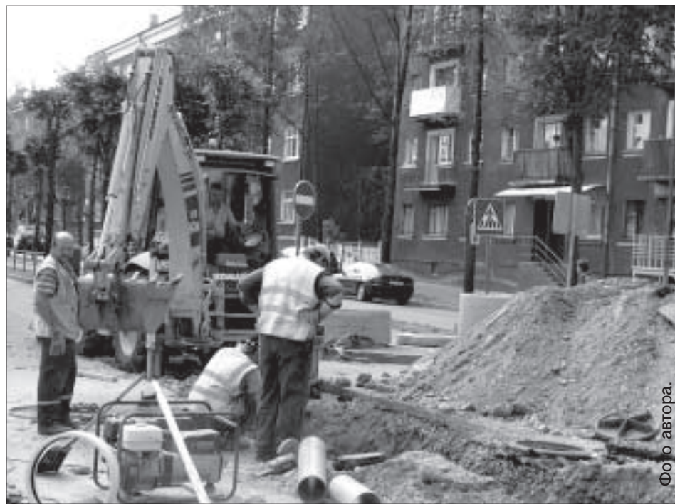
Идут строительные работы.
