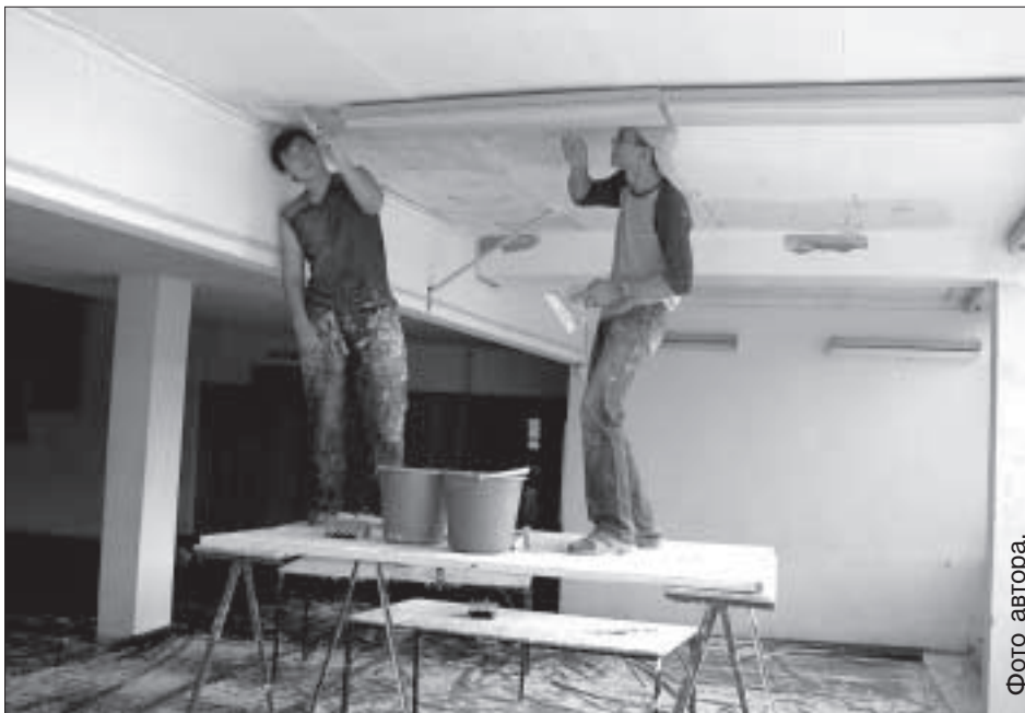
Идет ремонт малого зала ДКиС.
