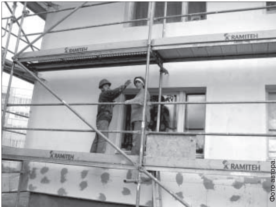
Работа на этом объекте для маляров строительной фирмы «ВСК» Нины Лапинской и Елены Рыбаковой скоро закончится.
