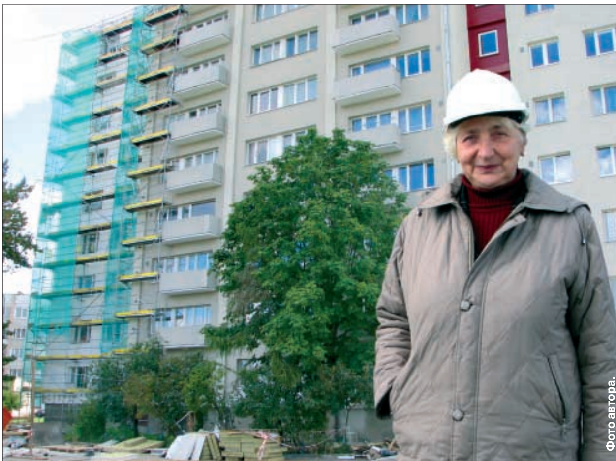
Работы по утеплению дома на ул. Виенибас, 38а ведет прораб Любовь Филиппова.
