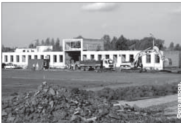
Строительные работы на стадионе идут полным ходом.
