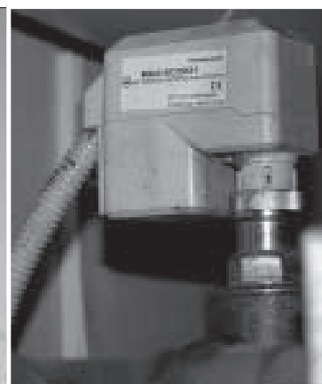
Вентиль, регулирующий подачу тепла.
