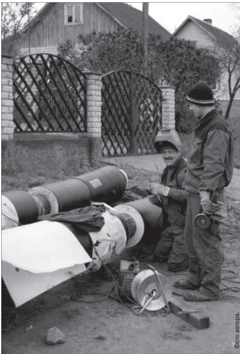
Ведется реконструкция теплотрассы.
