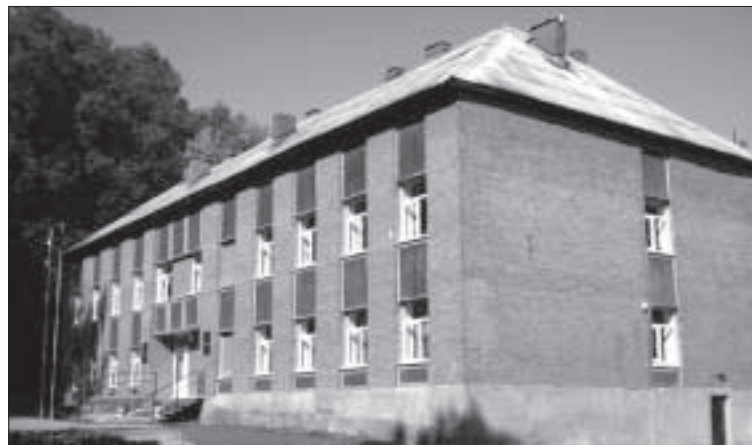
Новое здание просторное, но еще требует ремонта.
