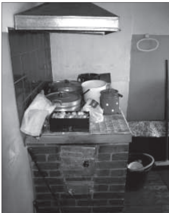
Плита на кухне отапливает спальню.
