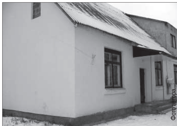
Социальные квартиры располагаются в здании бывшей почты и сберкассы.
