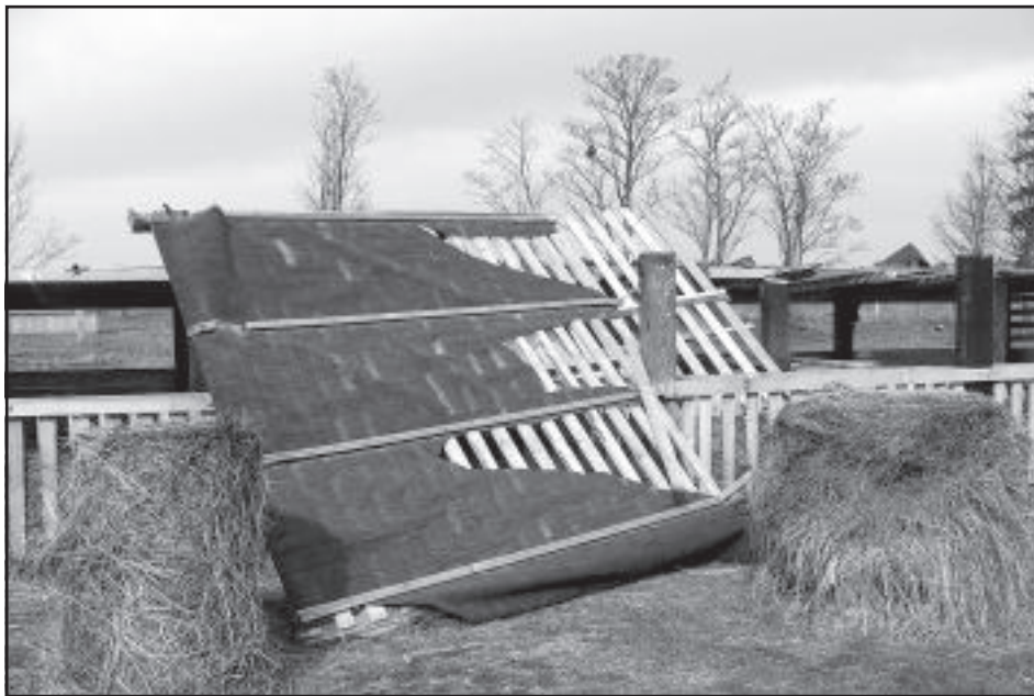
Фрагмент сорванной торнадо крыши.
