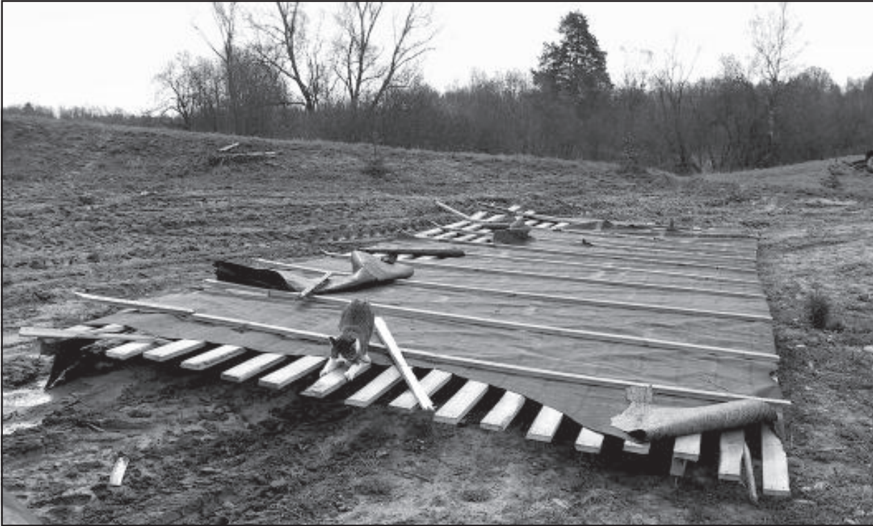
Этот кусок крыши унесло на 150 метров от ягнятника.
