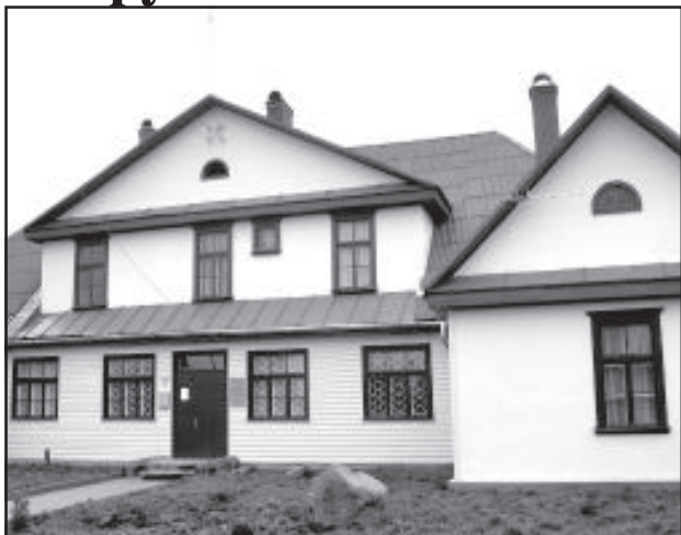
Так сейчас выглядит отремонтированное здание бывшего волостного совета.
