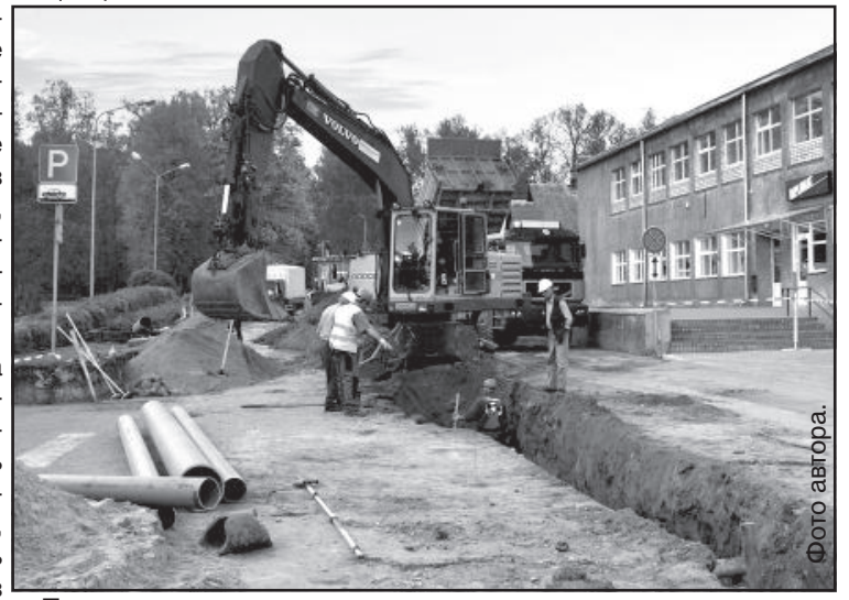
По многим улицам во время реконструкции водопровода невозможно проехать.
