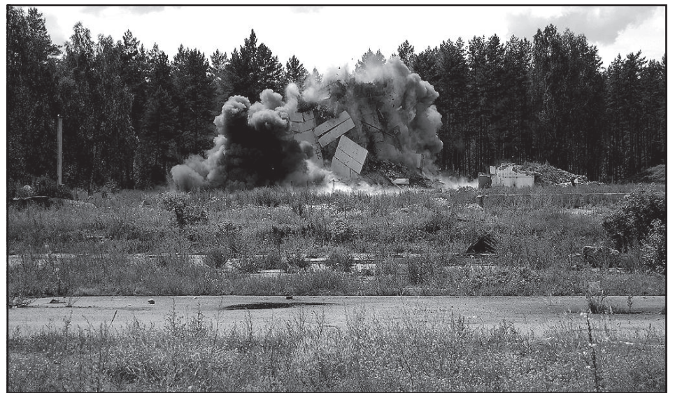
Необходимо просверлить несколько выемок, чтобы ослабить опоры конструкции и заложить взрывчатое вещество.
