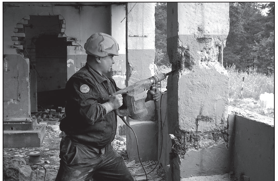
Необходимо просверлить несколько выемок, чтобы ослабить опоры конструкции и заложить взрывчатое вещество.
