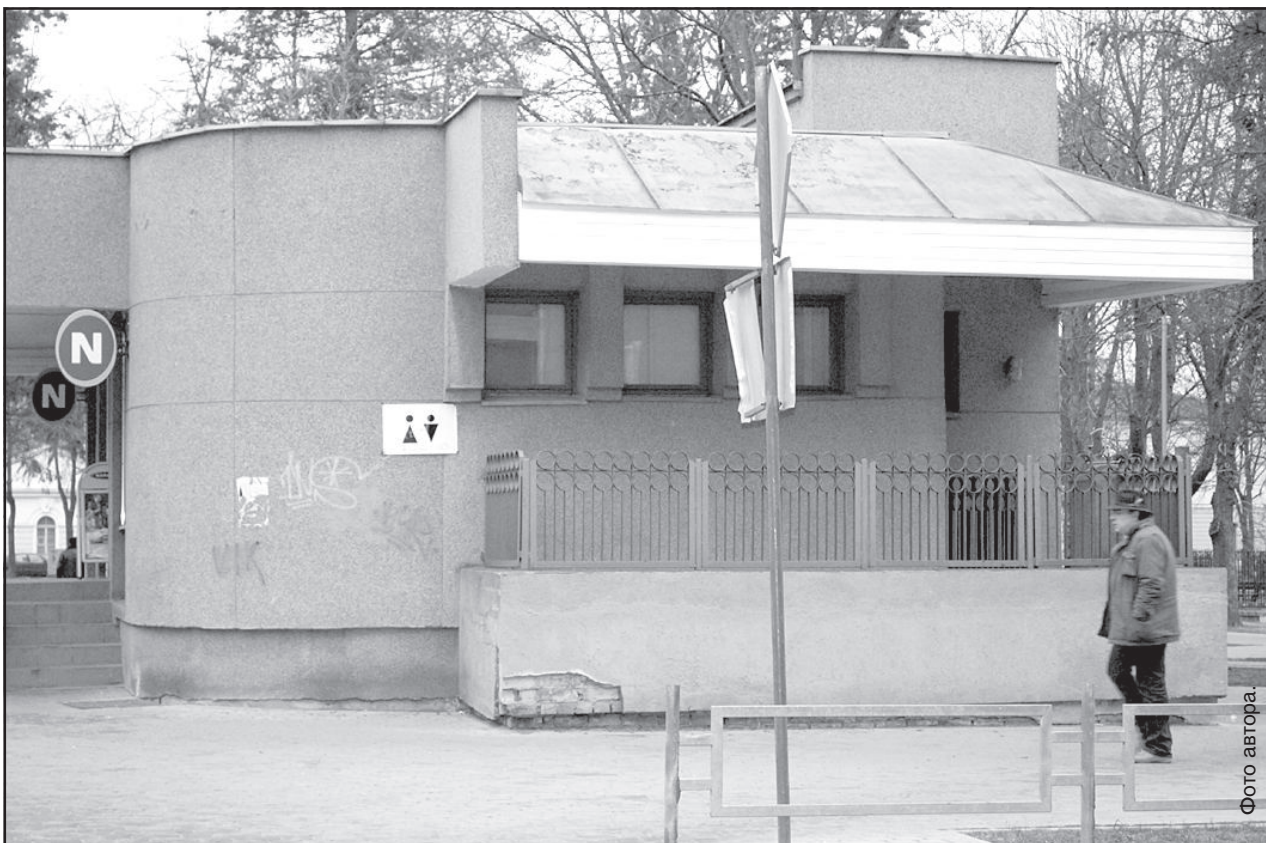
Туалет в сквере А. Пумпура был построен в 1934 году.
