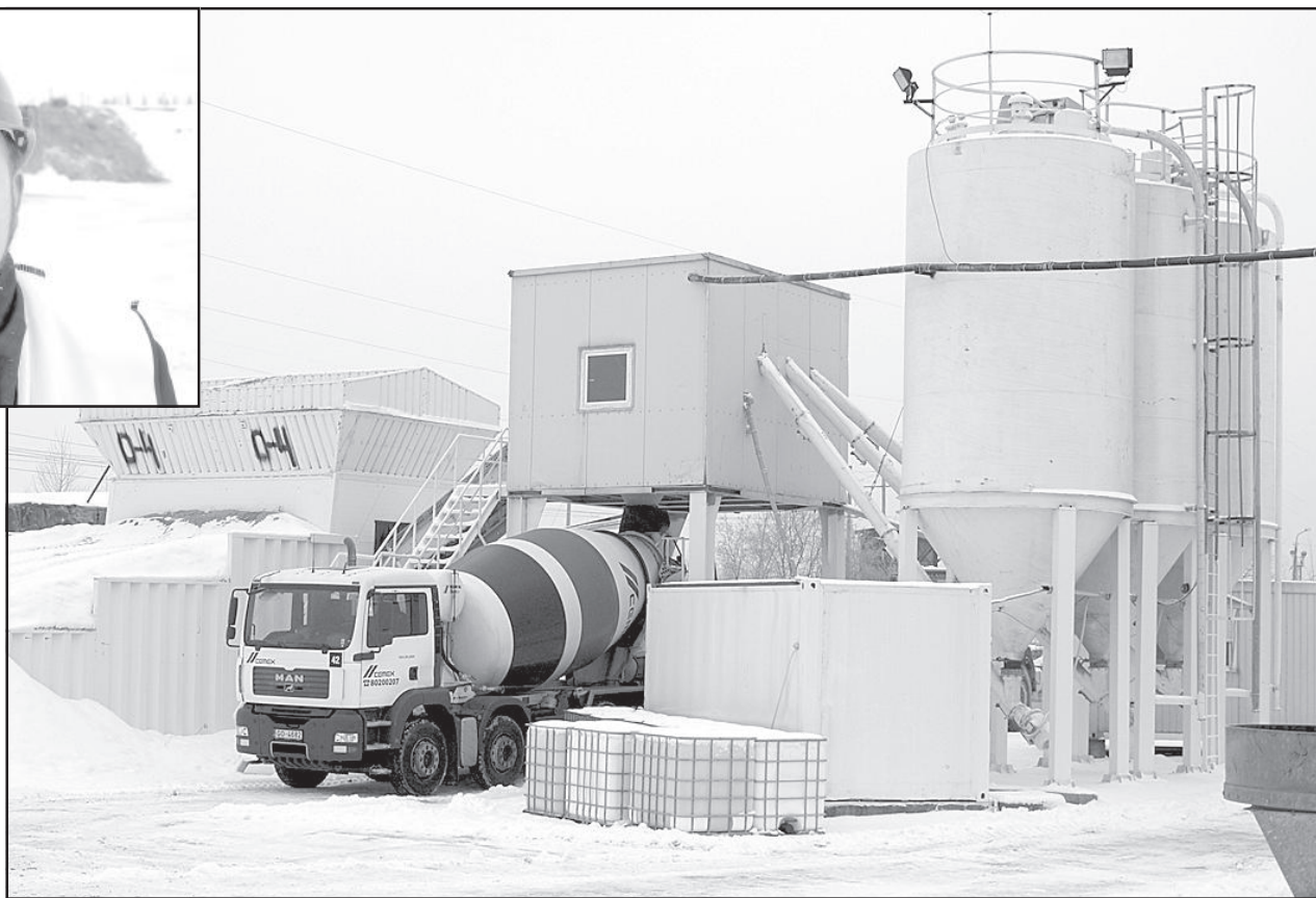
Так выглядит весь производственный комплекс.
