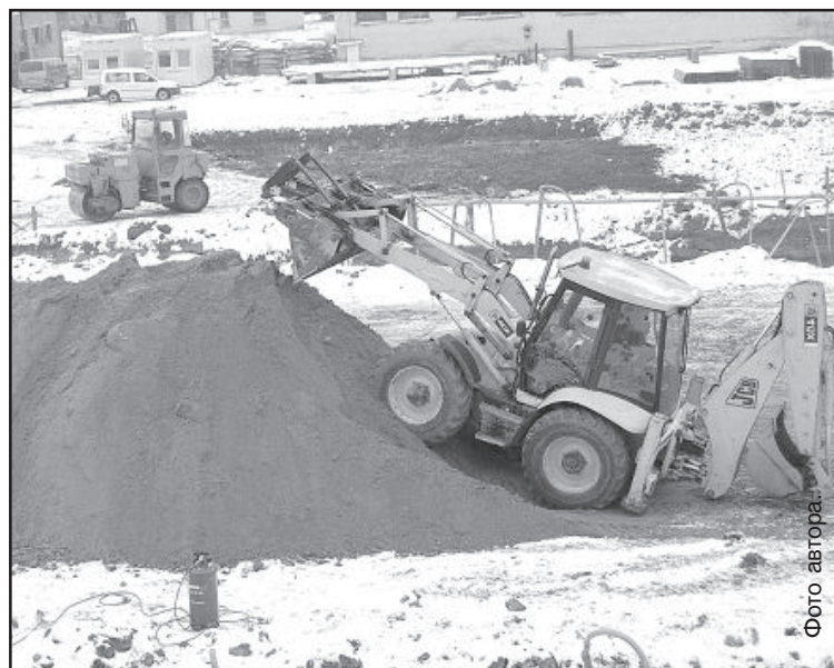
Строители проводят земляные работы.
