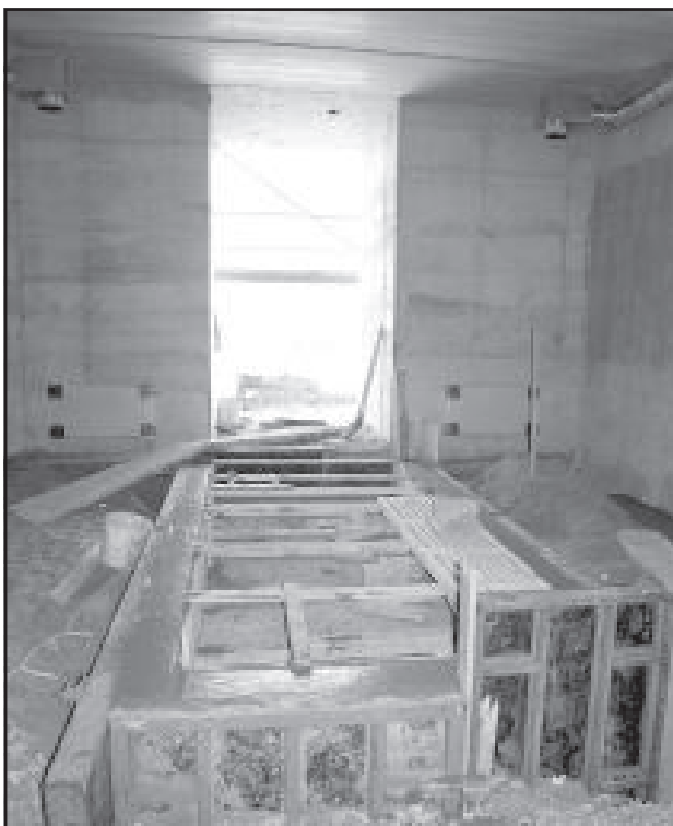
Здесь будет установлено оборудование для облучения.
