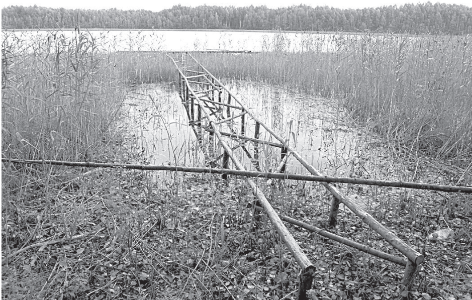
Строятся новые мостки для рыболовов.
