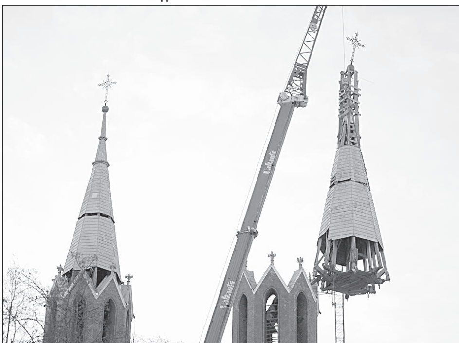
Идет демонтаж старых башен.
