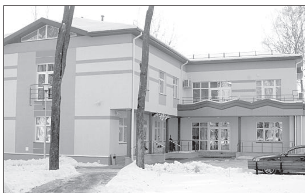
Отремонтированное здание больницы.
