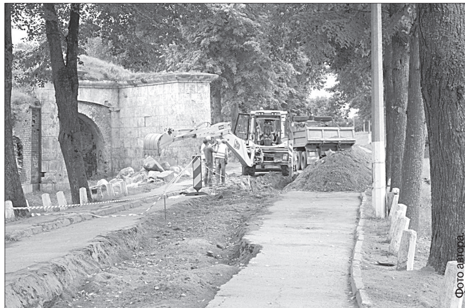
Прокладка труб у центрального входа в крепость.
