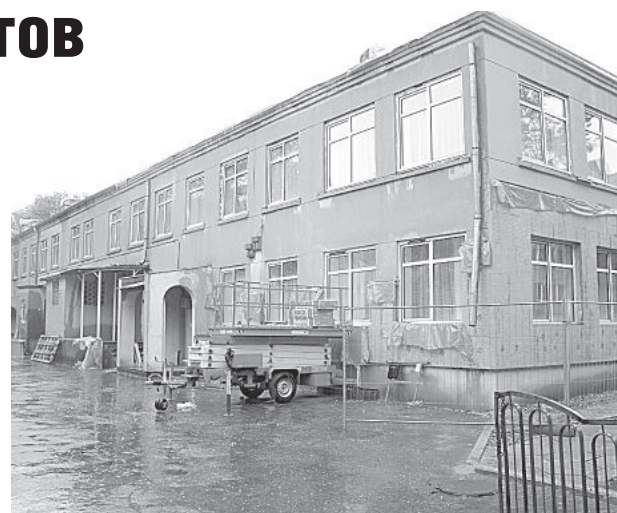
В дошкольных учреждениях Даугавпилса сейчас ведутся мероприятия по повышению энергоэффективности по техническому проекту и под стройнадзором компании REM PRO.
