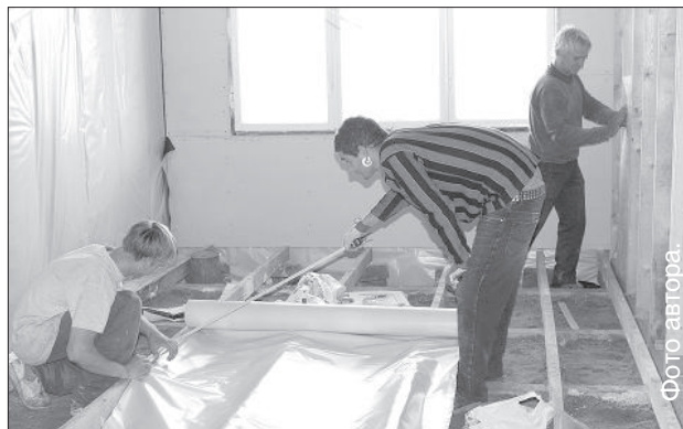
Строится новый дом.
