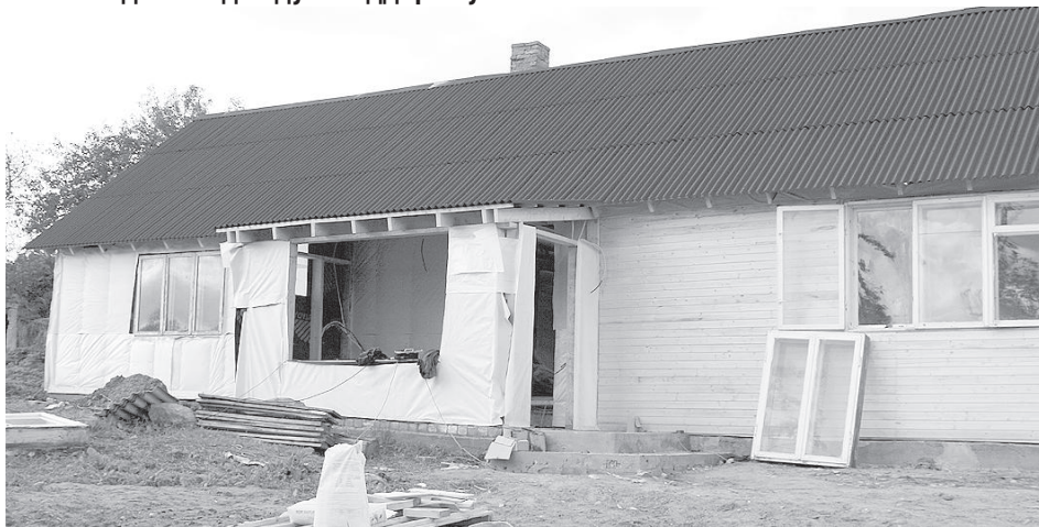
Строительство идёт без остановки, чтобы семья скорее могла бы вселиться.
