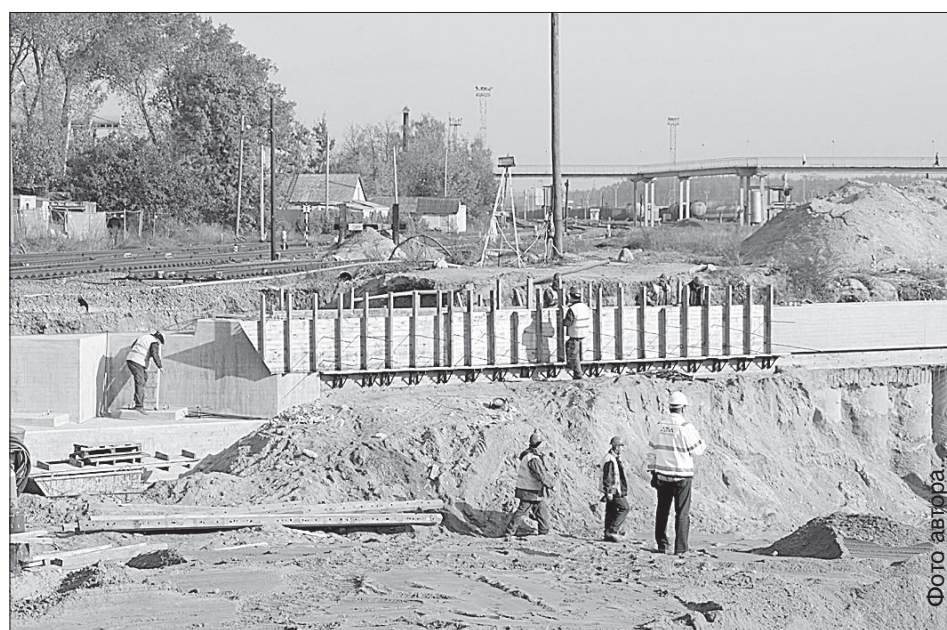
Работы на строительстве транспортной развязки идут по плану.
