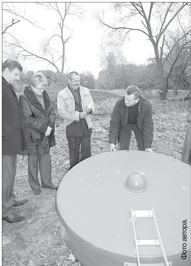
Откроют новую канализационную насосную станцию.
