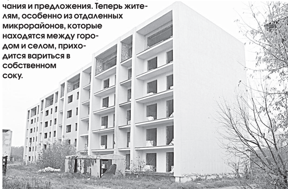
Отремонтированный и вновь разрушенный дом.
