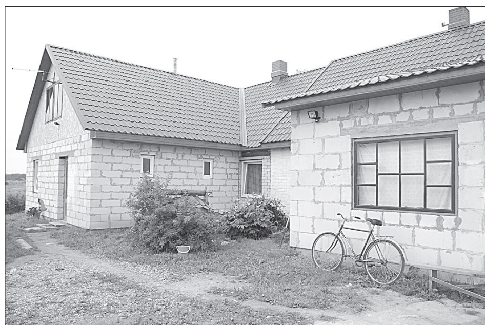
Разрушенный огнём дом постепенно восстанавливается.
