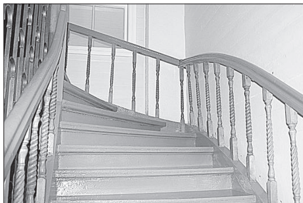
Восстановленная деревянная лестница.
