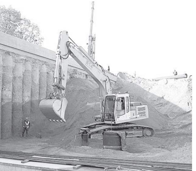
На строительстве транспортного узла.
