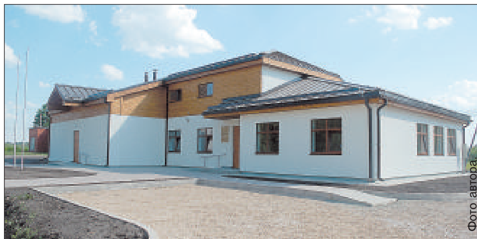
Новое здание Малиновского волостного управления.
