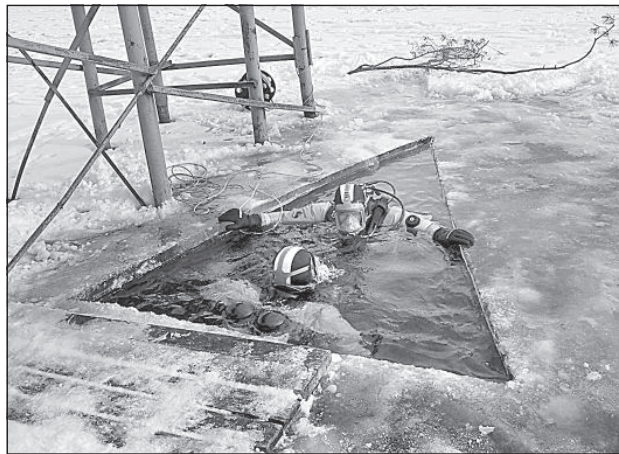
Подводные работы зимой.
