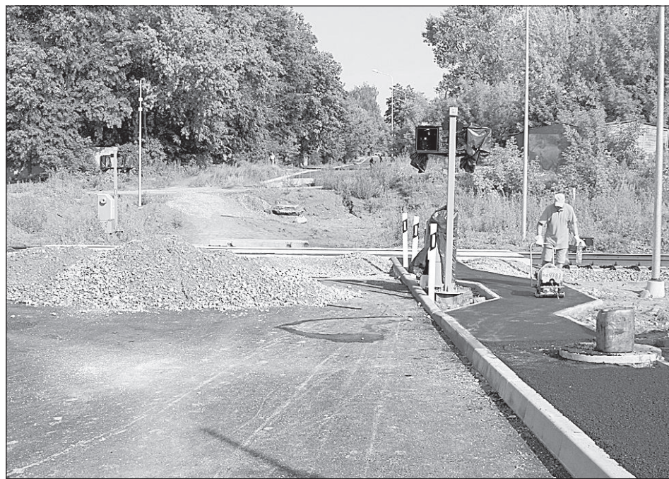
Новая дорога скоро соединит Ругели и микрорайон обувного комбината.
