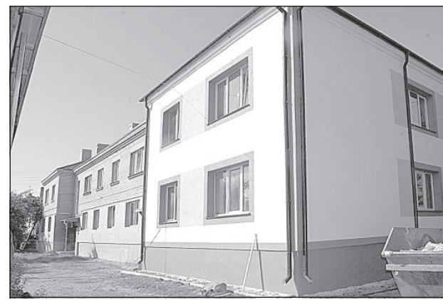
Одну сторону дома уже утеплили.
