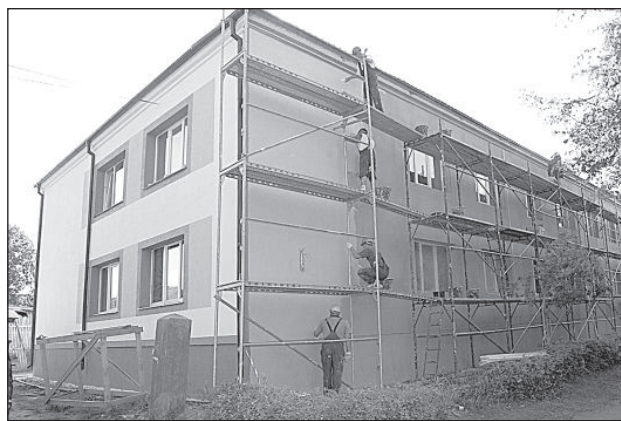
Строители продолжают работы по утеплению.
