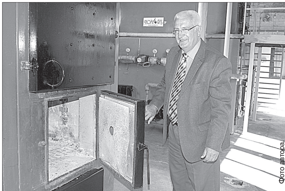
А. Айзбалт проверяет котельные.
