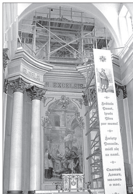
Скоро с алтаря будут сняты строительные леса.
