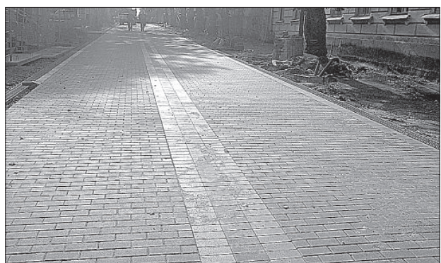
Укладка новой брусчатки на ул. Музея.
