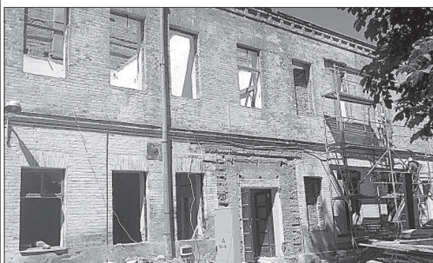
Демонтажные работы по ул. Саулес, 5А.
