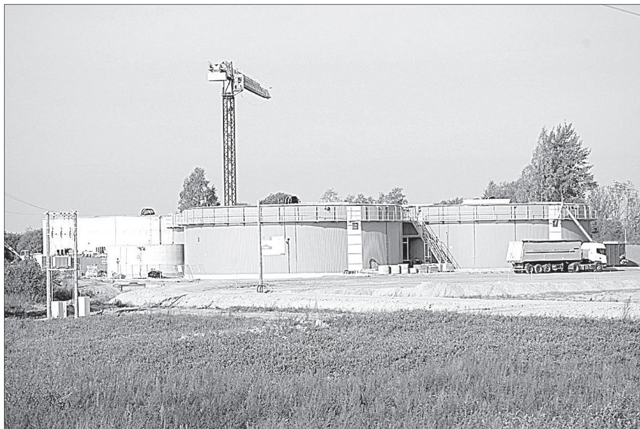
Станция биогаза на подъезде к Скрудалиене.
